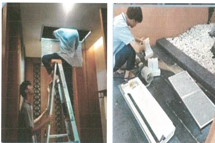
รูปภาพที่ 2.29 การทำความสะอาดเครื่องปรับอากาศ
